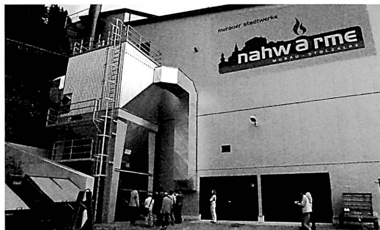
▲オーストリアの木チップバイオマス発電所 地域に熱供給もし世界初の再生可能熱100%で作るビール工場や、300床の病院、学校、一般住宅へも送っている。
